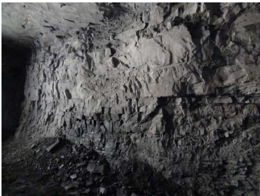
Рис. 2.9. Фотография трещиноватого массива скальных пород месторождения Жаман-Айбат (Казахстан)
