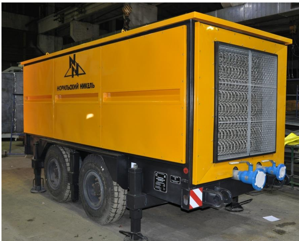
Рисунок 5.9 — Воздухоохладитель подземной системы кондиционирования КШР-350Н
