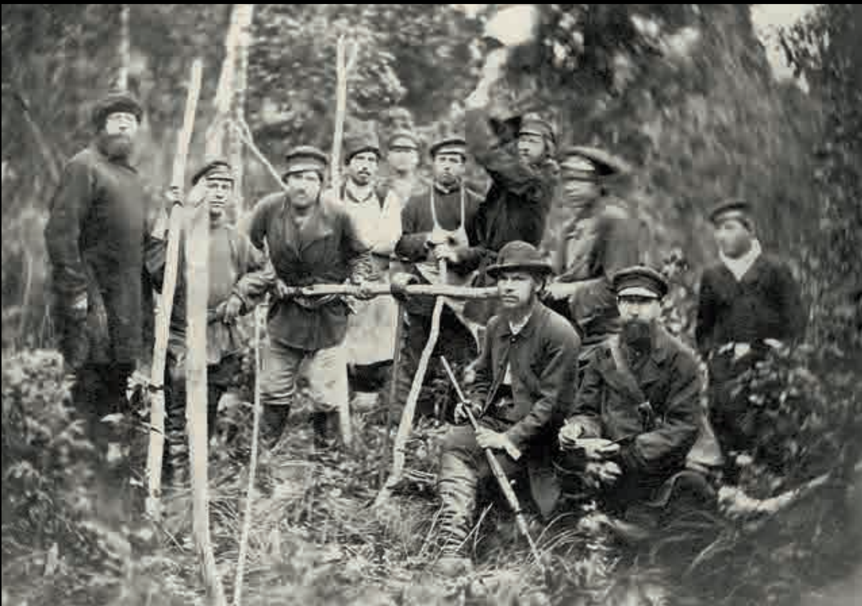
Работа щупом в поисках на руды в Перемской даче Добрянского завода, 1885. Из фондов Добрянского КМ
