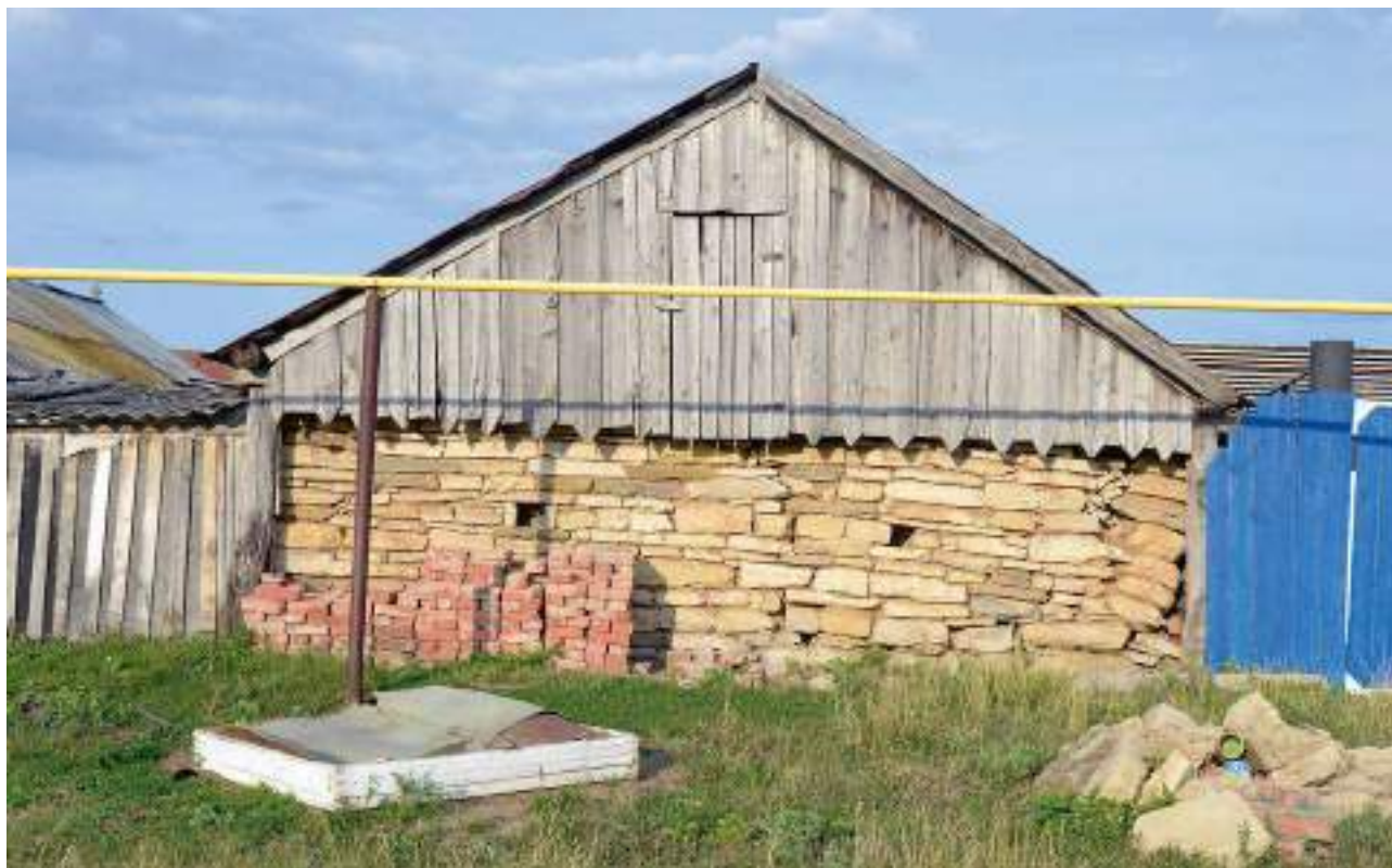
Хозяйственная постройка, сложенная из камня. Село Кубассы, 2019
