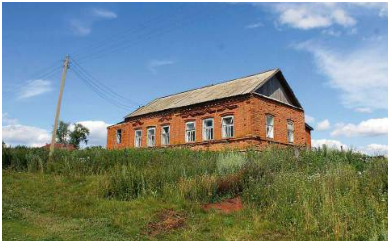
Старинный кирпичный дом. Село Большой Толкиш, 2019
